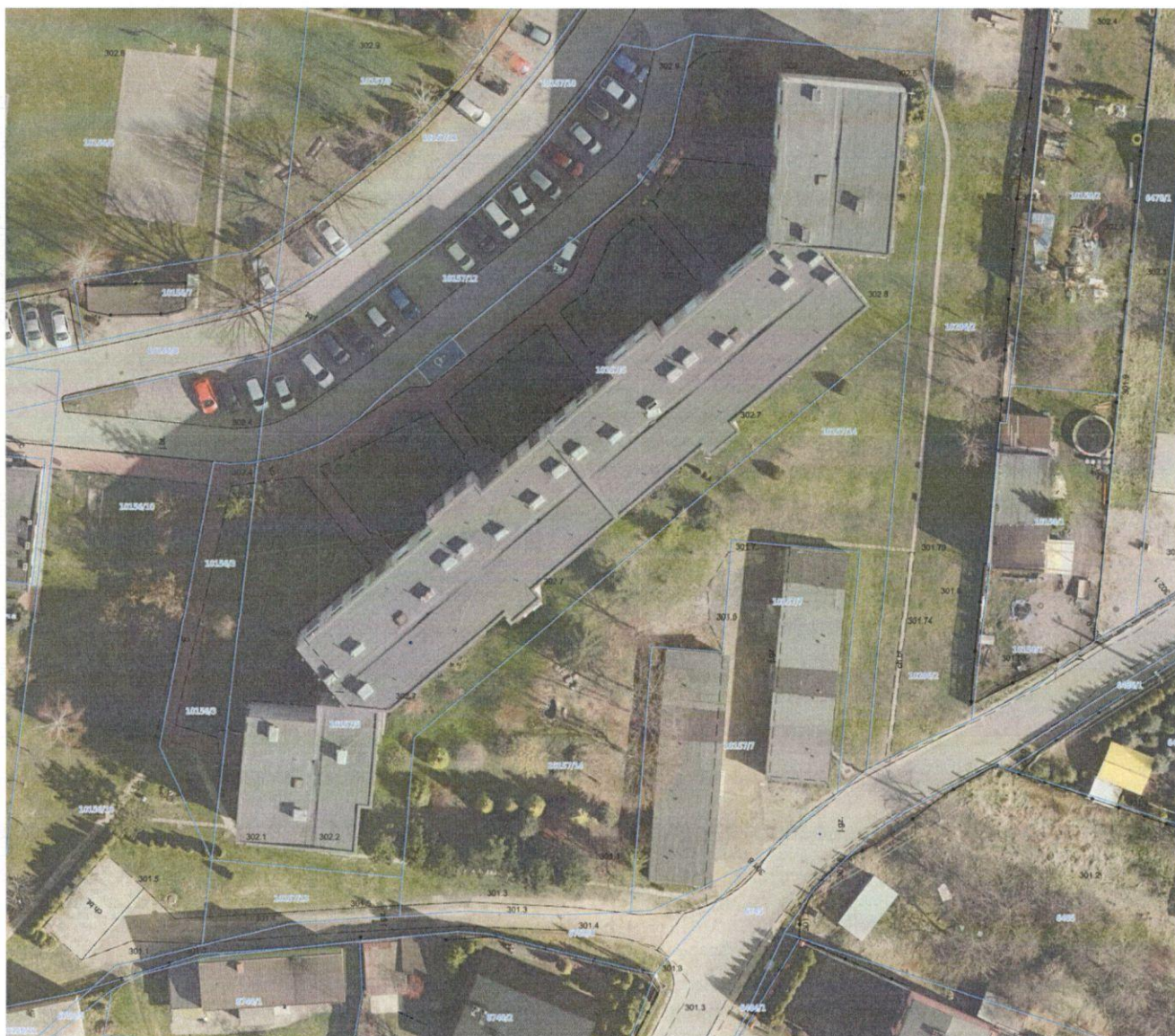
Rys. 1 Zdjęcie lotnicze budynku przeznaczonego pod montaż instalacji.
